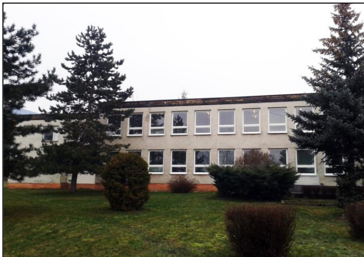
Budova MŠ s novými oknami, foto: archív školy
